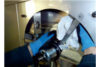
Czyszczenie silnika i komory wywiewnej filtra
