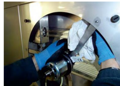
Czyszczenie silnika i komory wywiewnej filtra
