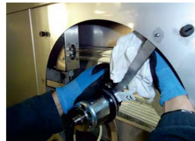
Czyszczenie silnika i komory wywiewnej filtra
