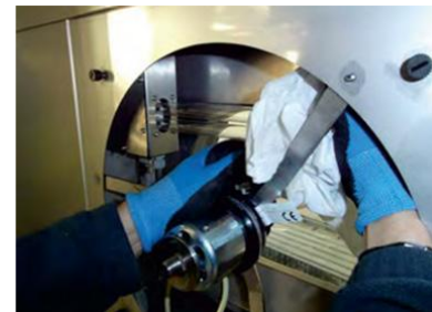
Czyszczenie silnika i komory wywiewnej filtra
