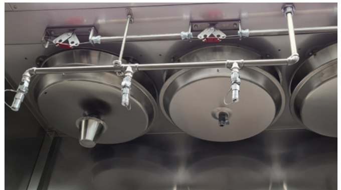
Elementy systemu przeciwpożarowego ANSUL - przewody, dysze
