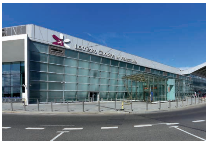
Lotnisko WARSZAWA OKĘCIE w Warszawie
